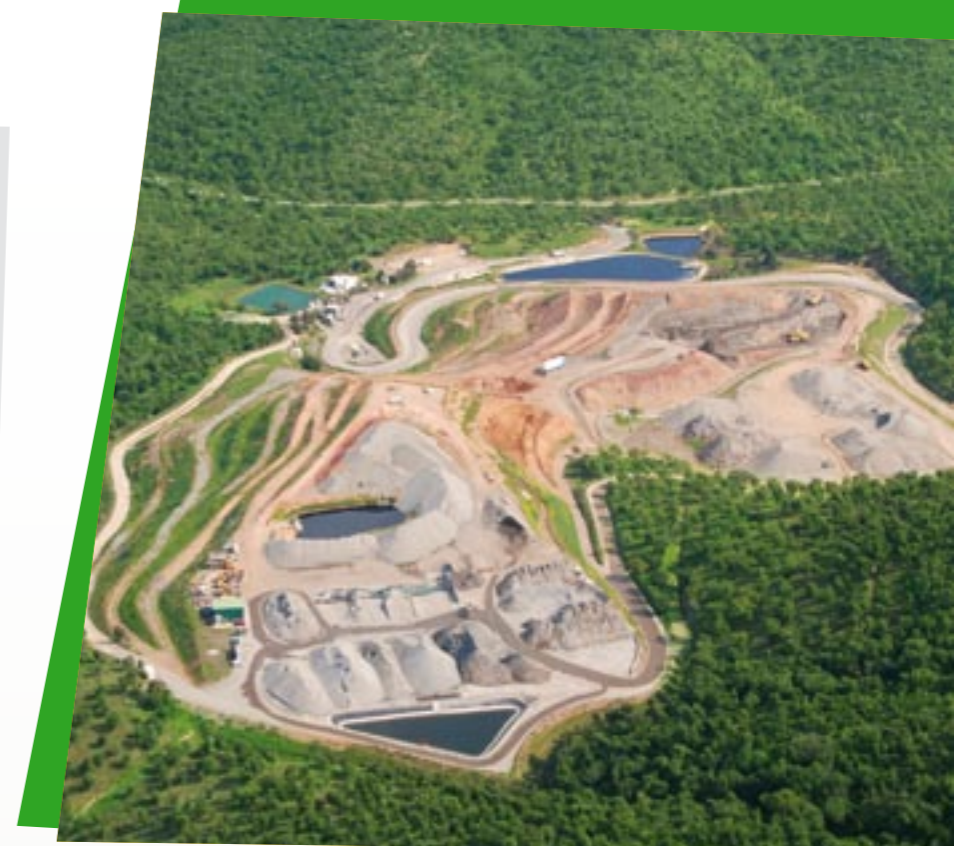
Centre de stockage de déchets non dangereux de Pierrefeu
